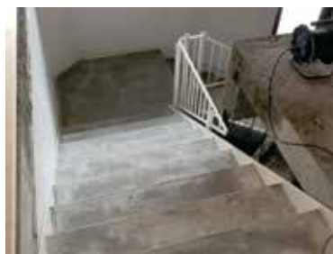
Den nye trappa opp til andre etasje i Klossen.
